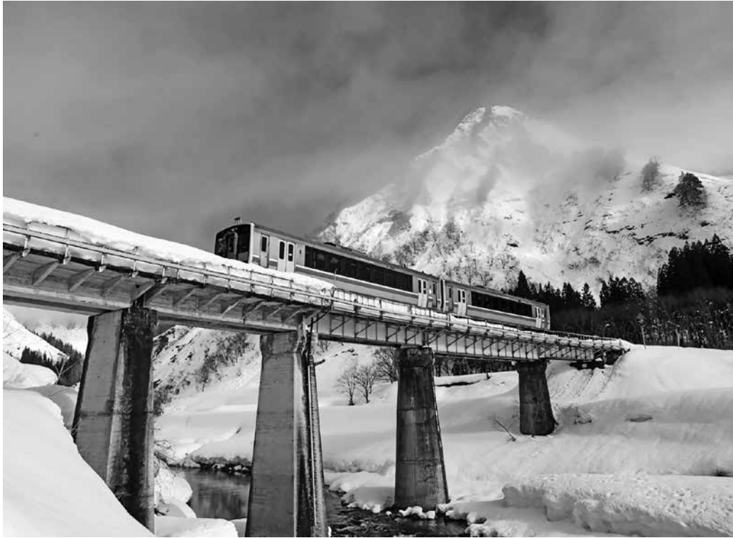
「全線開通の只見線」（只見町）
