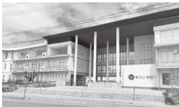
伊達市立梁川小学校新校舎
