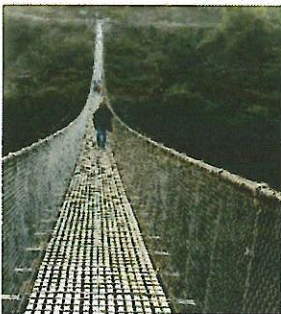
27.6mの吊り橋 (ネパール)
