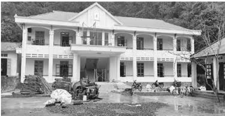
Lam Binh 郡, Phuc Yen 小学校, Na Kieng 分校, 建設
