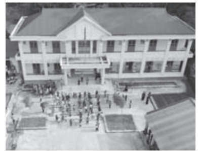
Lam Binh郡、Phuc Yen小学校、 Na Kieng分校、建設
